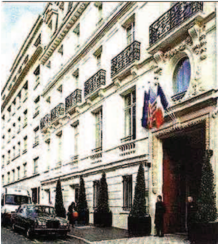
La façade de l'Hôtel InterContinental Paris avenue Marceau.
